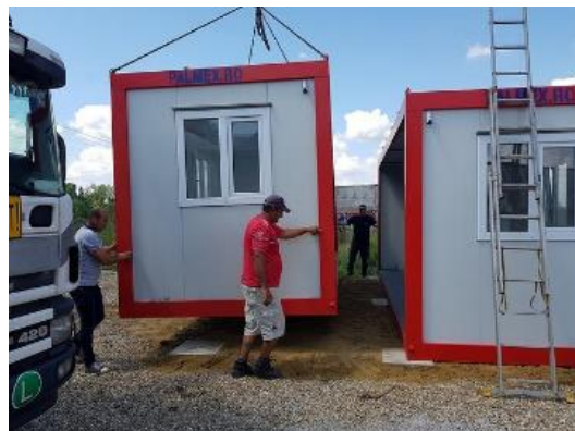
De containers worden gemonteerd tot een efficiënt schoolgebouw
